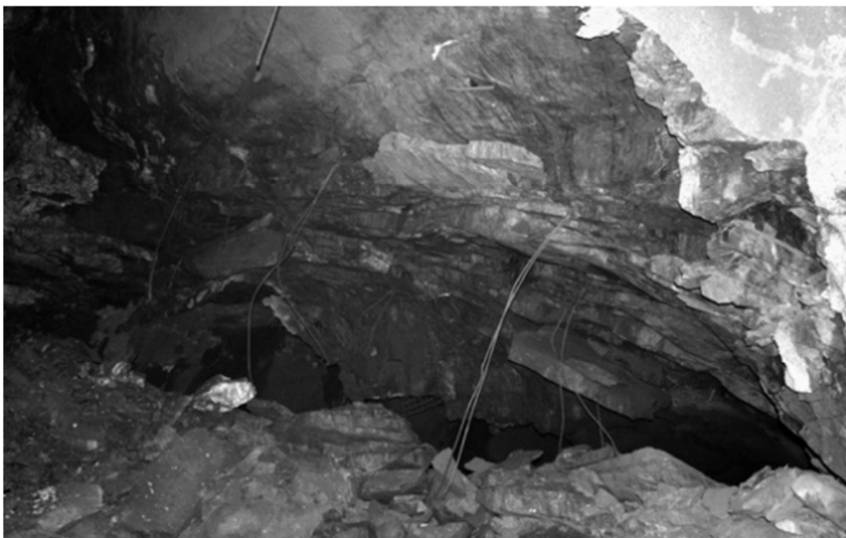
Рисунок 4.1 – Дугообразные трещины растяжения (растрескивание) в своде подготовительной выработки (рудник «Интернациональный»)
