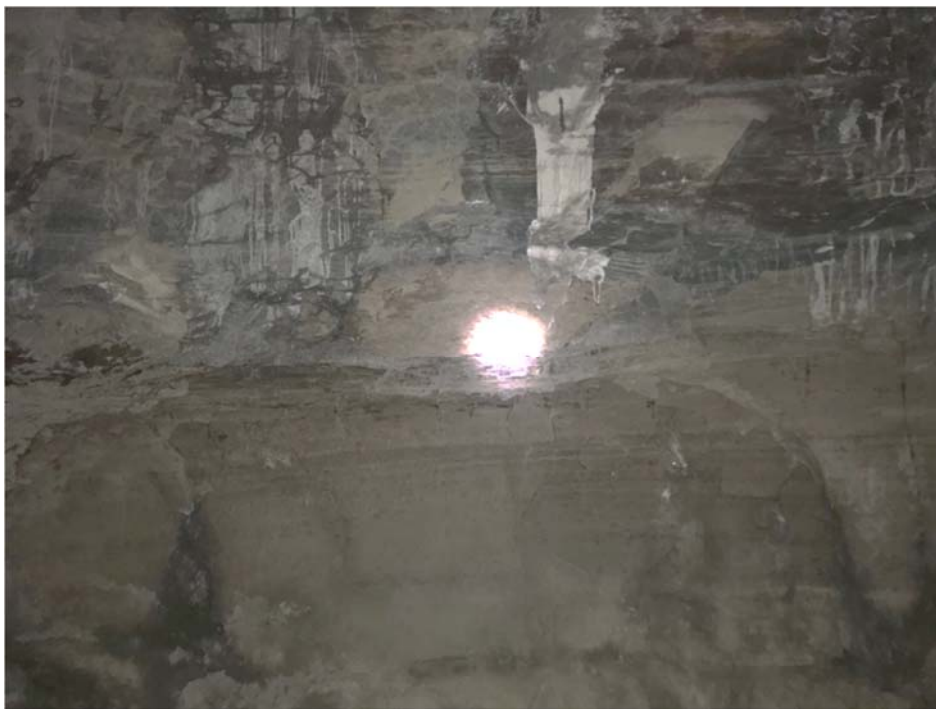
Рисунок 4.3 – Слоистая структура массива, сложенная бежевыми и серыми доломитами на участке спирального спуска
