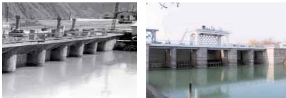
Рис. 1.4 – Система водообеспечения с водозабором раздельного типа с прямым отбором воды (Водохранилище Локтыши и Люблинское)
