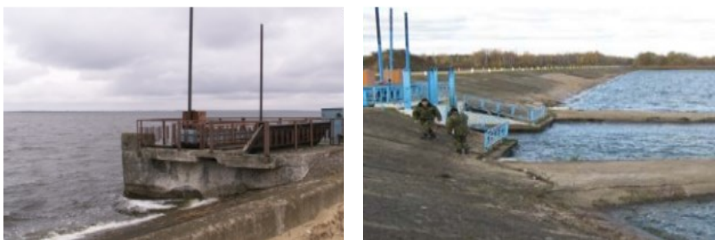
Рис. 1.4 – Система водообеспечения с водозабором раздельного типа с прямым отбором воды (Водохранилище Локтыши и Люблинское)
